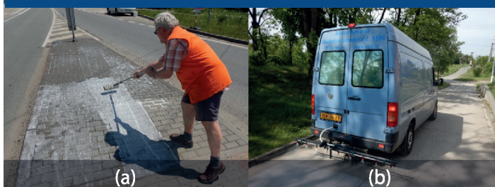
Obr. 3 možnosti aplikace Emulze LO na povrch betonu (a) ručně, (b) strojně
